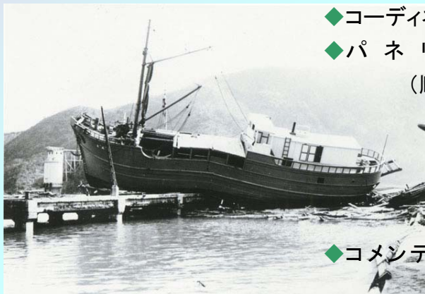
写真：昭和南海津波の被害(須崎市HPより掲載)
